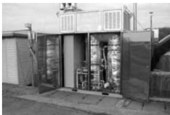
図4 吸湿液加熱再生装置
