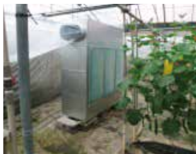
写真2 温室内に設置した除湿ユニット
