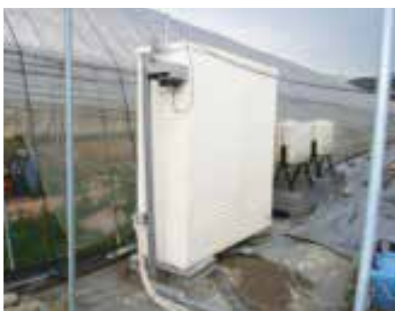
写真1 温室外設置型の吸湿液再生ユニット
