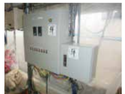
写真3 温室外に設置した壁掛型制御ユニット
