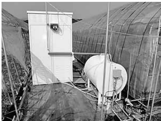
図2 開発した農業ビニールハウス用除湿機 (ハウス外に設置した吸湿液再生ユニット)
