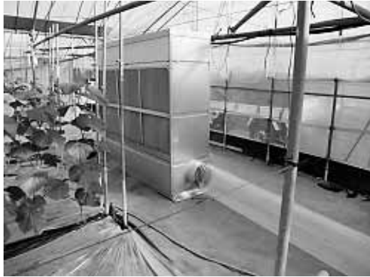
図1 開発した農業ビニールハウス用除湿機 (除湿空気はビニールダクト上方へ送風)
