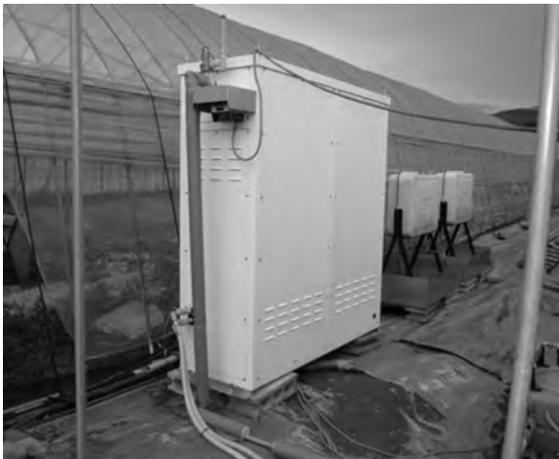
図 1b 吸湿液用いた農業温室用除湿機の再生ユニット
