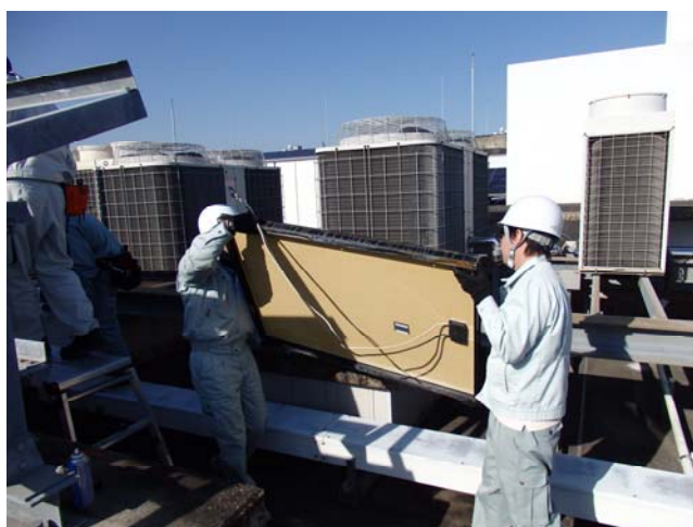
図 10 モジュール運搬状況
