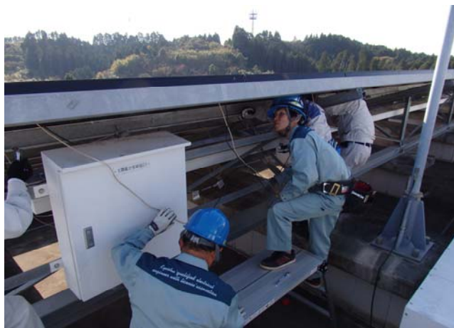
図 9 モジュール取り外し状況
