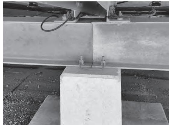
図11 等電位化を目指した施工状況
